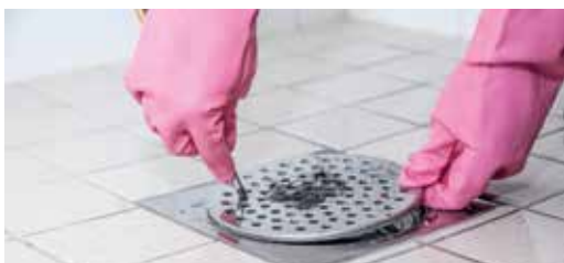
1. Irrota lattiakaivon kansi, vaikka ruuvimeisselin kärjellä nostamalla.
