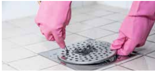
1. Irrota lattiakaivon kansi, vaikka ruuvimeisselin kärjellä nostamalla.
