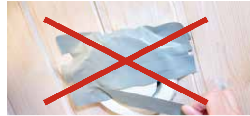
3. Älä koskaan peitä venttiiliä! Älä myöskään muuta venttiin säätöjä pyörittämällä venttiin lautasta.
