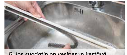
6. Jos suodatin on vesipesun kestävä, pese se miedossa saippuavedessä, anna kuivua, ja laita suodatin takaisin paikoilleen.
