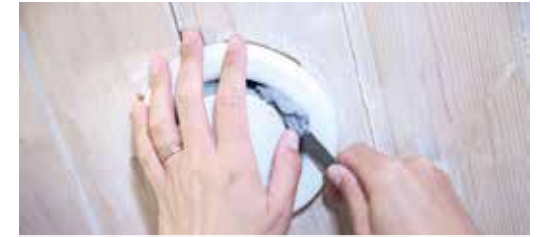
2. Poista keittiön poistoilmaventtiin kasaantunut rasvainen pöly varovasti ohuella työkalulla, esim. veitsellä.
