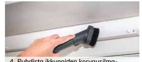
4. Puhdista ikkunoiden korvausilmaventtiilit imurilla ja tarvittaessa pesemällä venttiin sisällä oleva suodatin (kts. kohdat 5. ja 6.).
