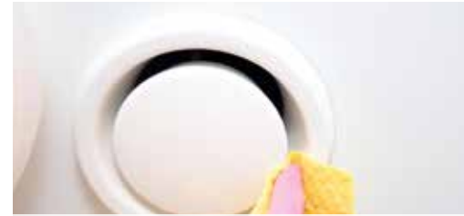
1. Puhdista ilmanvaihtoventtiilit imuroiden tai pyyhkimällä vähintään kaksi kertaa vuodessa.
